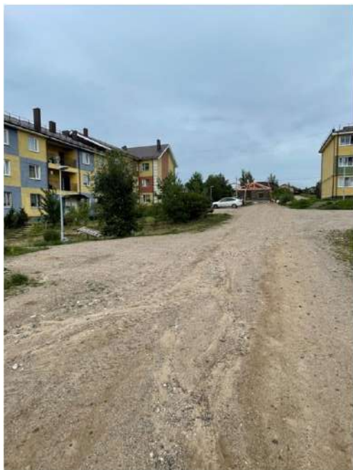
с. Бурашево до ремонта
